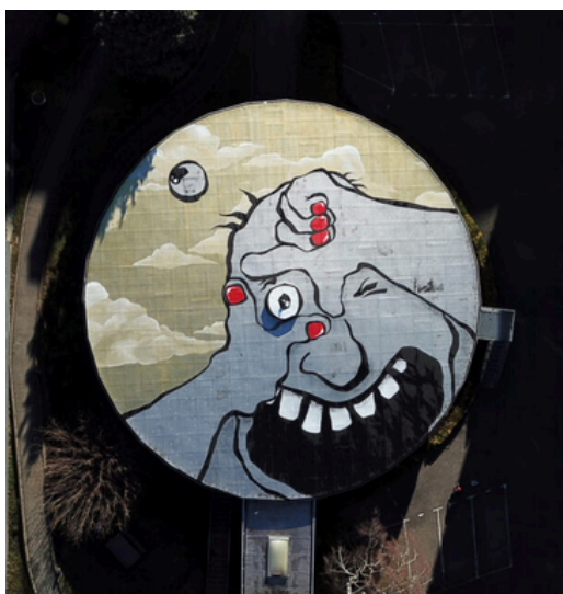
Bâtiment "La Soucoupe" - 158 Cr Fauriel, La Rotonde - Ecole des Mines Saint-Etienne
