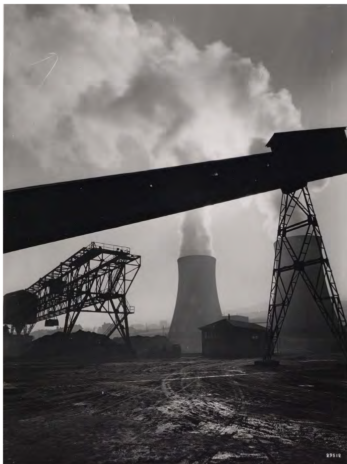
Jean-Baptiste Lassablière (1882-1952) Le Chambon-Feugerolles, construction de la centrale thermique du Bec 1949 Couriot-Musée de la Mine, DOC2022.17.26
