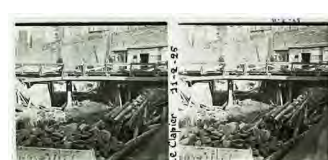
ANONYME Saint-Étienne, Le Clapier, travaux de terrassment de la gare 1924-1925 Couriot-Musée de la Mine, inv. 2023.1.1
