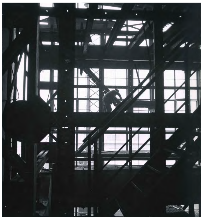
Anna Chojnacka (1914-2007) Mine Walenty-Wawel à Ruda Śląska, construction d'une chaufferie 1960 inv. MHK/F/ACH/1031
