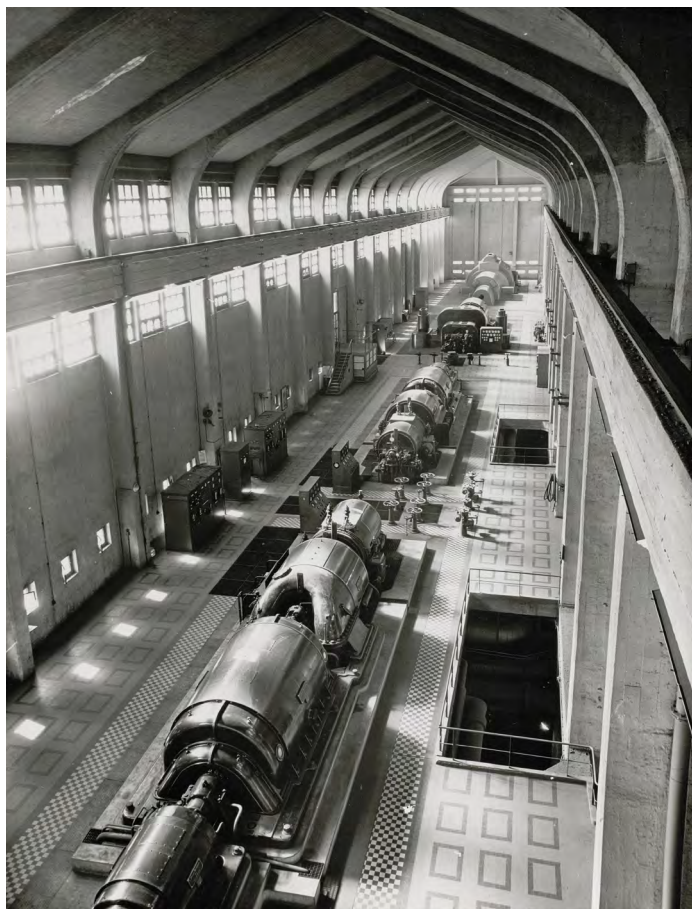
Ito Josué (1924 – 2010) Centrale électrique du Bec, Le Chambon Feugerolles, salle des compresseurs vers 1950 Couriot-Musée de la Mine, inv. 2008.0.859
